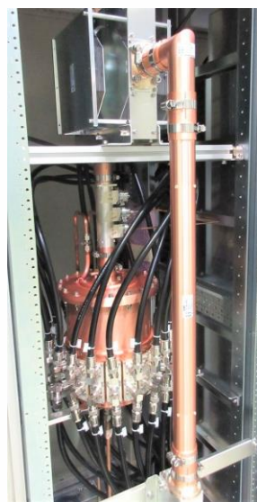
小型半同軸空洞 36合成器 Q値10000以上 合成数と設置状況に適した 径寸法(任意)に製作します
